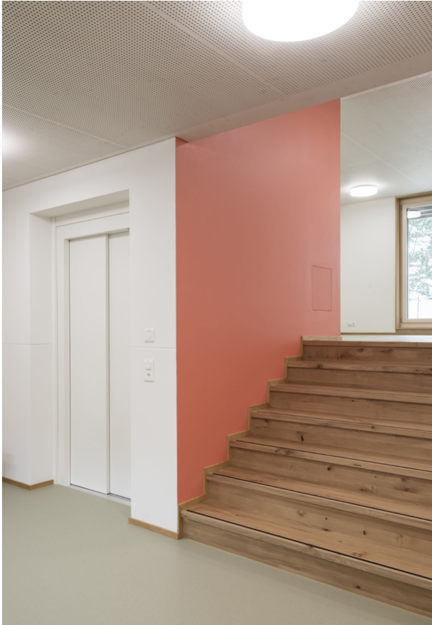
Treppengänge mit Eiche Massivholzplatten
