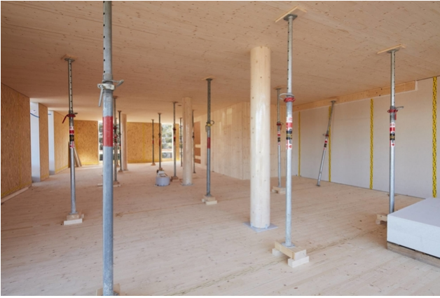
Während dem Aushärten des Gießscharzes müssen die Geschossdecken zusätzlich abgestützt werden
