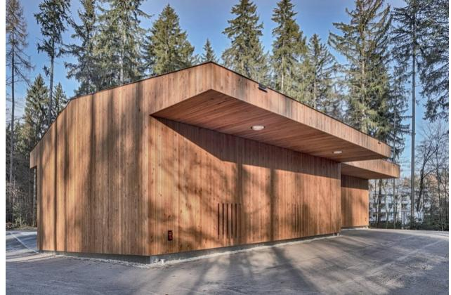
Für das Forsthaus musste natürlich das Holz aus dem eigenen Forst verwendet werden. Entsprechend musste darauf geachtet werden, dass die Bauteile eine Verwendung des eigenen Holzes nicht erschweren.
