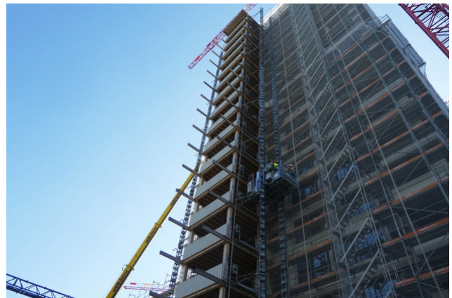
Gerüsteturm von unten
