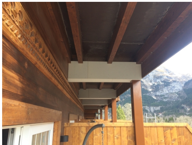
HEB Träger verkleidet
