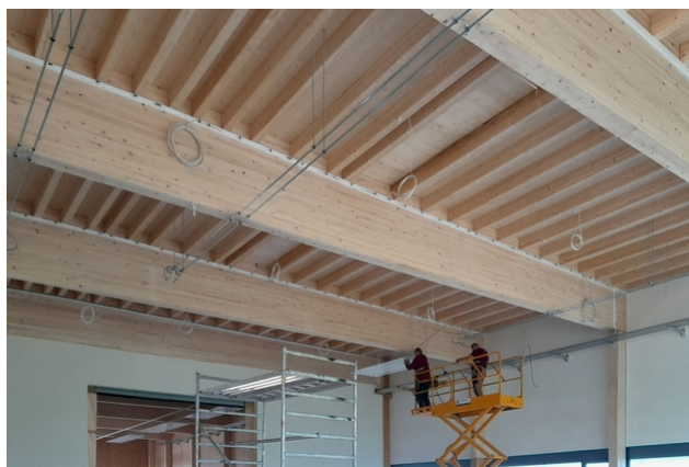
Bau der Hallendecke
