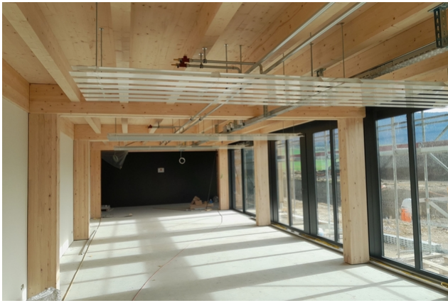
Innenansicht des Bürobereichs
