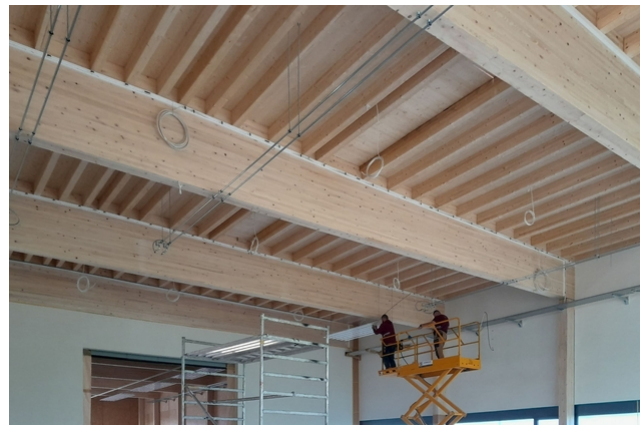
Bau der Hallendecke
