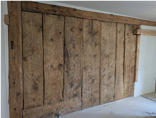
Bohlenwände als Bestandteil der Aussenwandkonstruktion.
