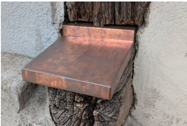
Konstruktiver Holzschutz hilft, das Fachwerk vor eindringender Feuchtigkeit zu schützen.
