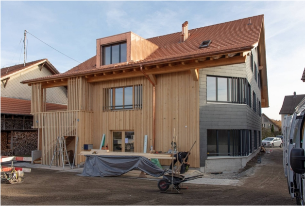
Brandschutzfassade zum Nachbarhaus
