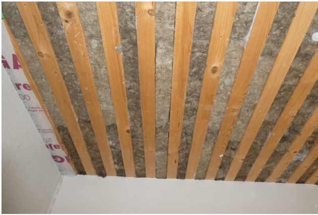
Deckendämmung im Scheunenumbau.
