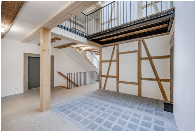
Kombination der neuen mit den bestehenden Bauteilen im Mittelteil
