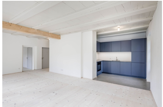
Sichtbarer Untergurt des Vierendeelträgers
