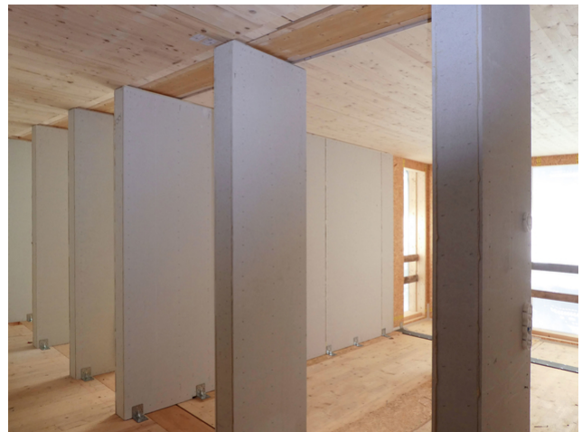
Blick ins Innere: Im Vordergrund sind die Stützen zu sehen, welche die Decke tragen
