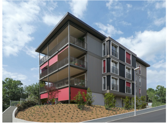
An den Erkeren werden zu einem späteren Zeitpunkt weitere Solarpanels montiert
