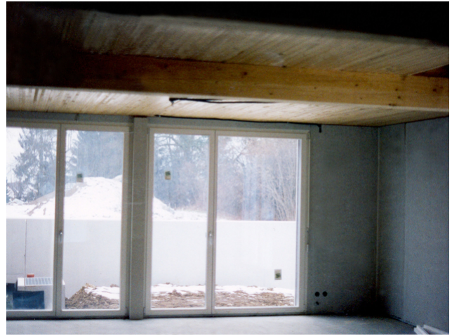
Ein Blick ins Wohnzimmer im Rohbau
