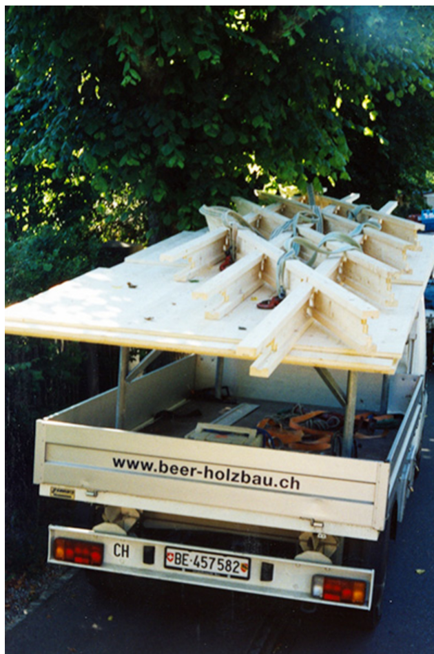
Anlieferung zusammengeklappter Trägerrost
