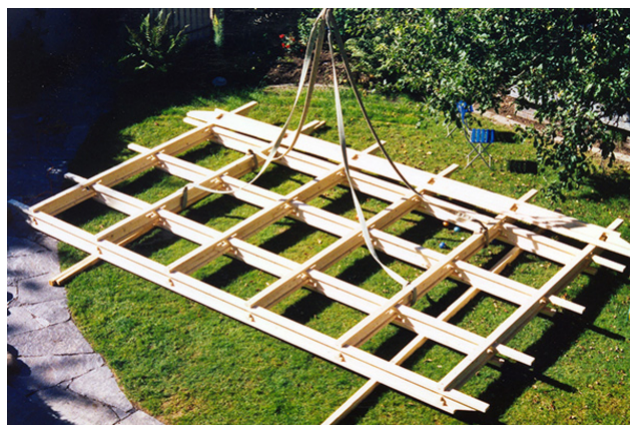
Ausklappen Trägerrost auf ebener Fläche und Einbau Rand- und Verstärkungsträger
