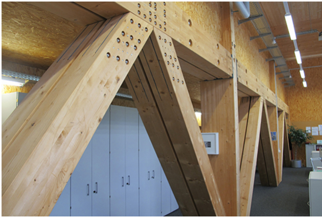
Fachwerkträger im Bürotrakt
