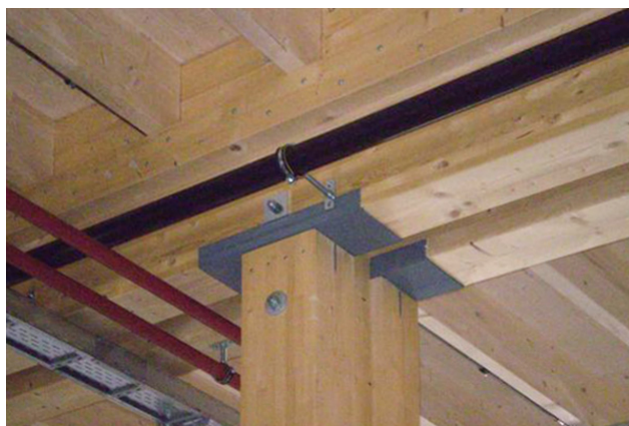
Querdruckverstärkung mit Stahl-U-Profil, Nebentragwerk auf Traglatten
