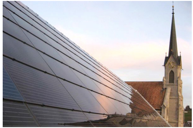
Holzelementdach mit Photovoltaik Anlage für Stromgewinnung
