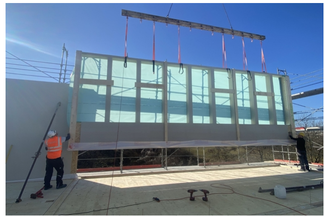
Aufrichtung von vorgefertigten Wandelementen
