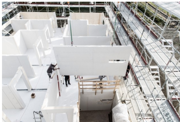
Montage der brandabschnittsbildenden Innenwände
