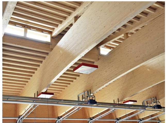
Detailaufnahme der grossen und schweren Holz-Bogenbinder
