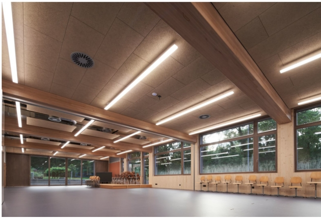
Mehrzweckraum mit den Unterzügen aus Buchenholz und den Falttrennwänden
