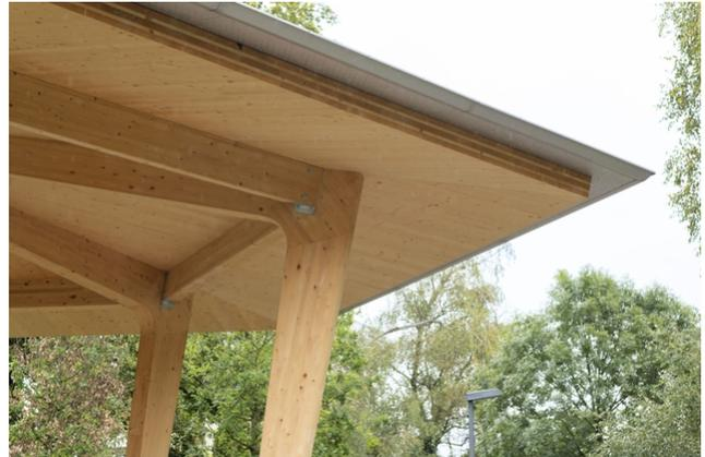
Clever konzipiert - nachhaltig gebaut. Timbatec brachte seine Expertise in der Holzbaustatik, den L-Stützenoptimierungen sowie bei konstruktiven Details ein – mit Fokus auf Kreislaufwirtschaft und minimalem Einsatz von Verbindungsmitteln.
