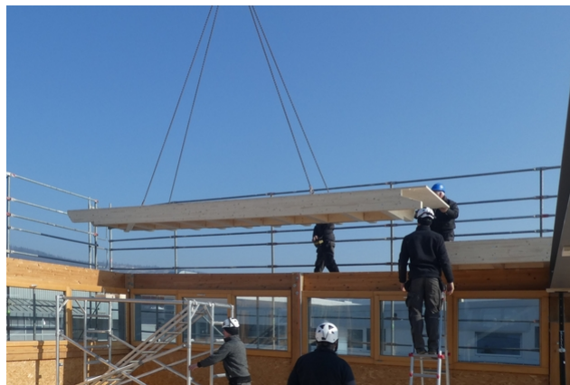
Anbringen eines Dachelements
