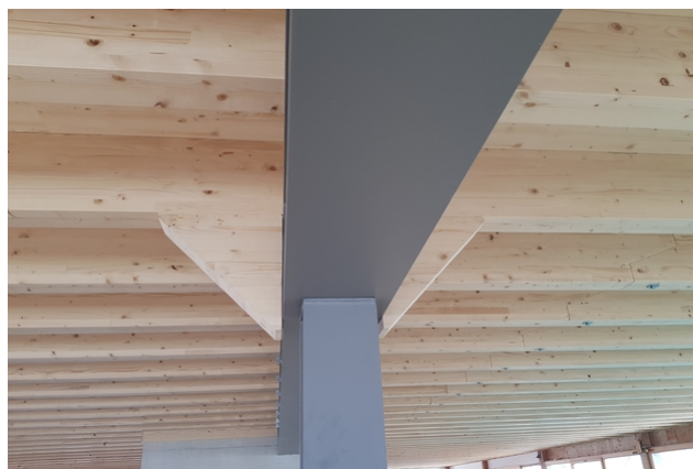
Kombination von Stahltragwerk und Holzbau
