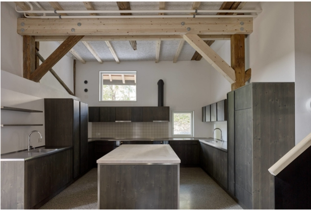
Ertüchtigtes Tragwerk über der Küche
