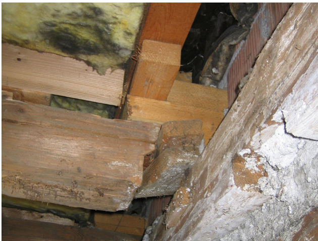
Trägerunterstützung OG vor der Sanierung
