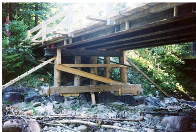
Notbrücke mit Stahlträgern
