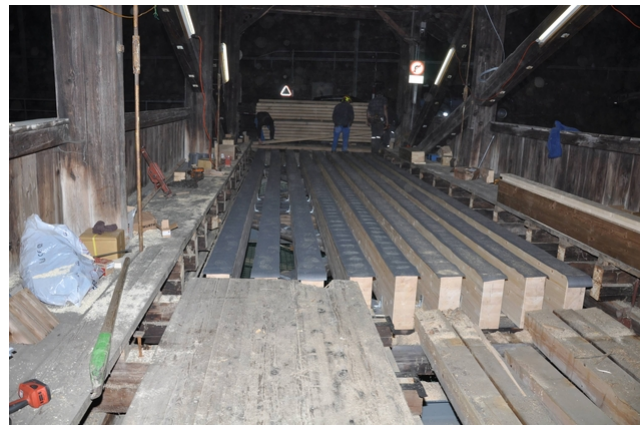
Montage neue Längsträger in der Nacht
