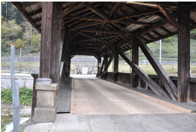
Neue Fahrbahn mit luftumspülten Eichenbrettern
