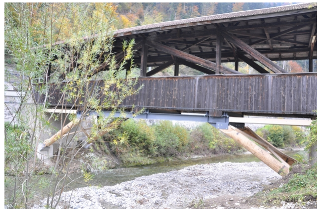
Ansicht der Brücke nach der Sanierung
