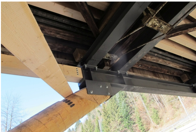
Anschluss der Eichenstämmen und Druckstäbe
