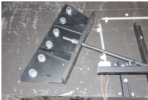
Befestigungen der Zugstangen mittels Stahlplatte
