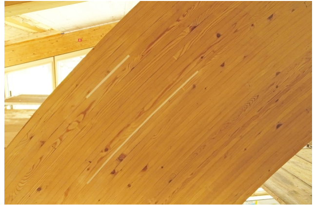
Detailansicht einer sanierten Klebstoffuge
