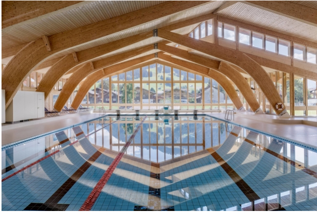
Beeindruckende Ausmasse: Tragkonstruktion des Hallenbads
