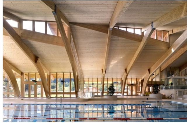
Zwischen den Bindern wurde das Akustiktäfer erneuert
