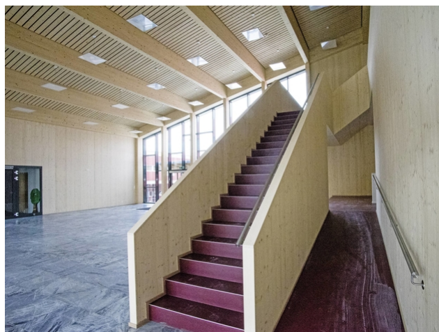
Viel Holz: Blick ins Innere des neuen zweigeschossigen Verbindungstraktes
