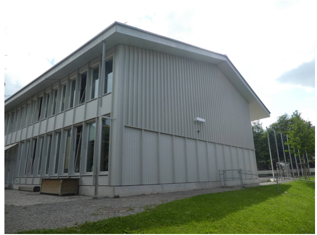
Fassade Ansicht Nord
