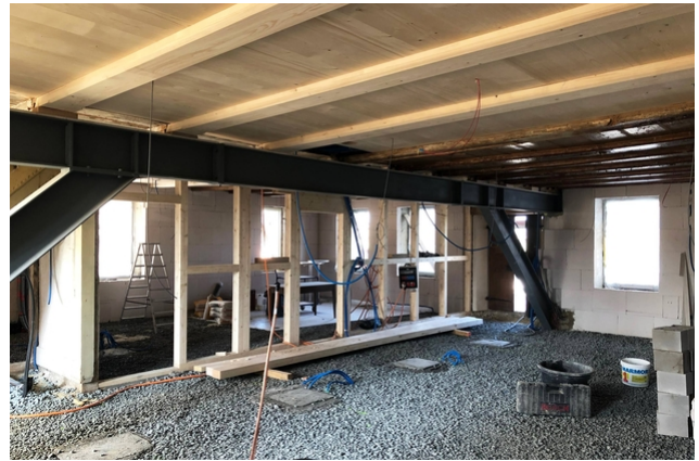
Stahlträger im Altbau
