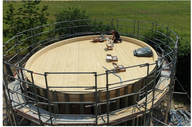
Verguss der TS3 Fuge
