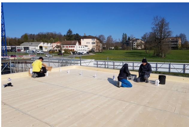
TS3 beim TS3-Verguss des Vordachs
